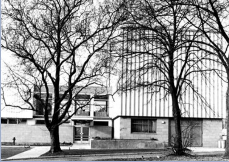
Abb. 3 Laborgebäude und HEM-Halle
