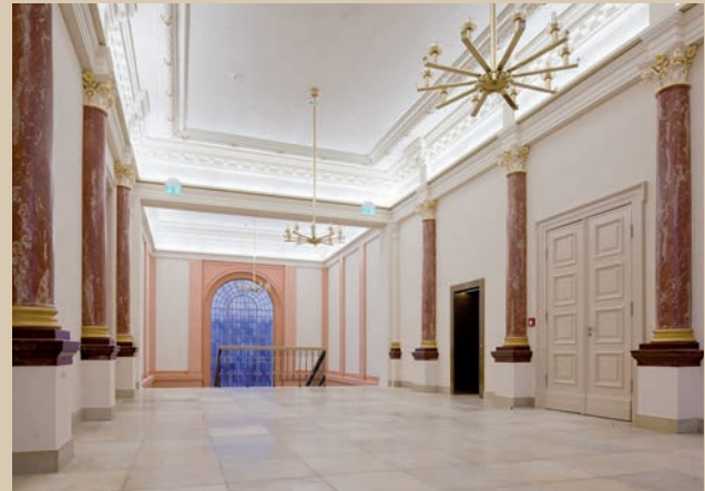
Abb. 15: Foyer, 1. Obergeschoss mit sanierten Scagliola-Halbsäulen
