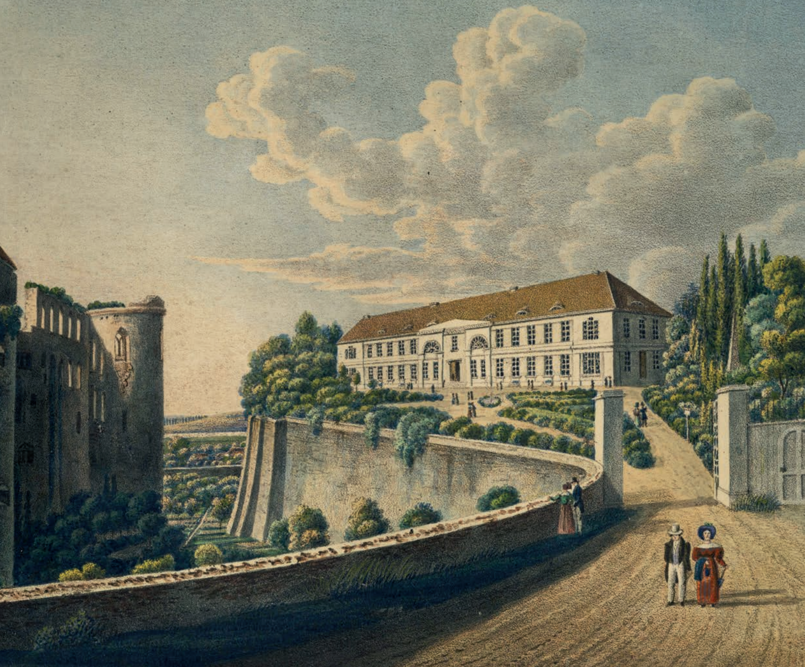
Abb. 2: Historische Ansicht des in den 1820er Jahren errichteten ersten Gebäudeteils für die Freimaurerloge „Zu den drei Degen“ (rechts) gegenüber der Moritzburg (links)
