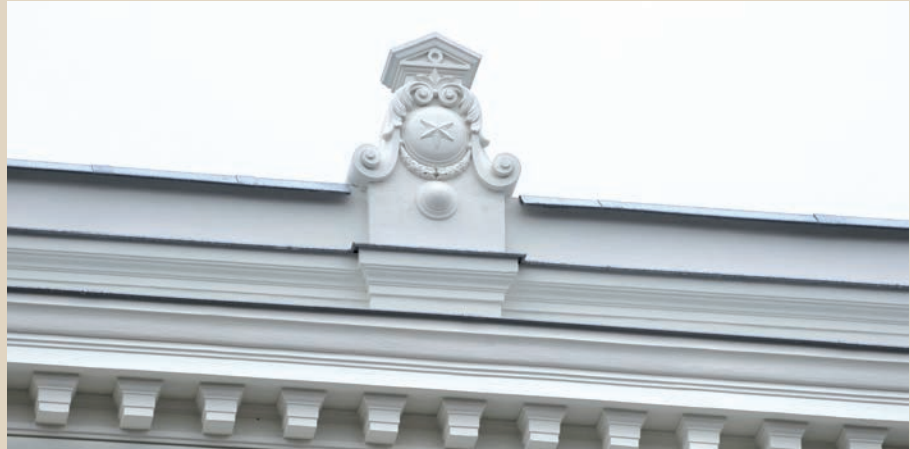
Abb. 52 und 53: Restauriertes Kapitel und Attikaufsätze an der Außenfassade
