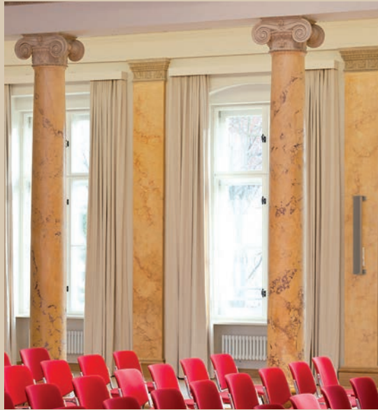
Abb. 32: Sanierung einer Scagliola-Säule im Festsaal
