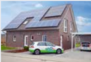
Abbildung 3: Einfamilienhaus mit PV-Dachanlage 41
