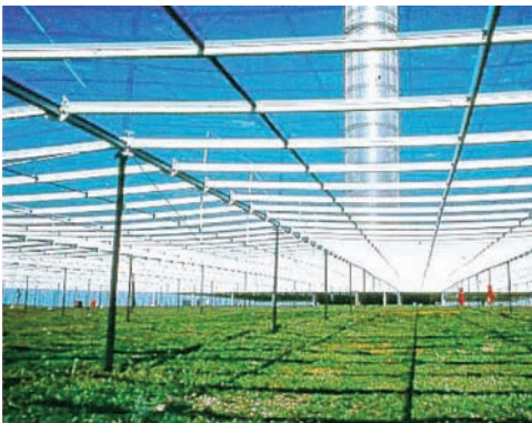
Abb. 13 Glaskollektor des Prototyps in Manzanares, Spanien
