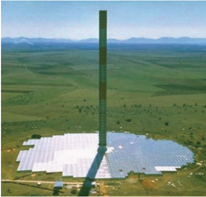
Abb. 11 Aufwindkraftwerk Prototyp bei Manzanares, Spanien
